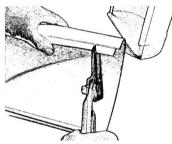
Liegt die Baulänge der Kappe fest, können die Öffnungen für den Rohraustritt in die Deckelhälften mit Hilfe einer Blechschere (IDEALoder Lochschere) geschnitten werden. Hierbei ist zunächst anhand einer Deckelhälfte, die man zur Armatur hält, zu prüfen, wie der Armaturenkörper in der Kappe zu liegen kommt. Zur Anpassung der Kappe an die
